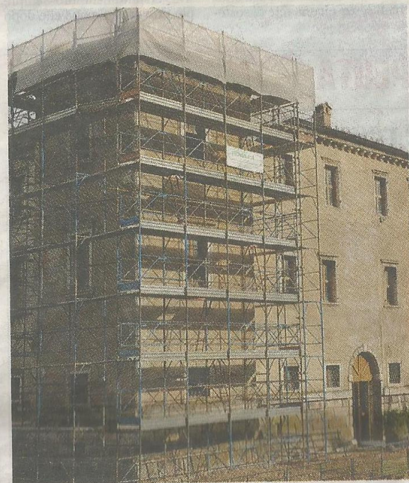
Al palazzo delle Albere i lavori per adeguare gli impianti e per l'ascensore
